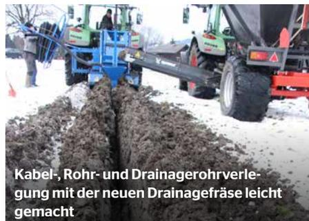
Kabel-, Rohr- und Drainagerohrverlegung mit der neuen Drainagefräse leicht gemacht
