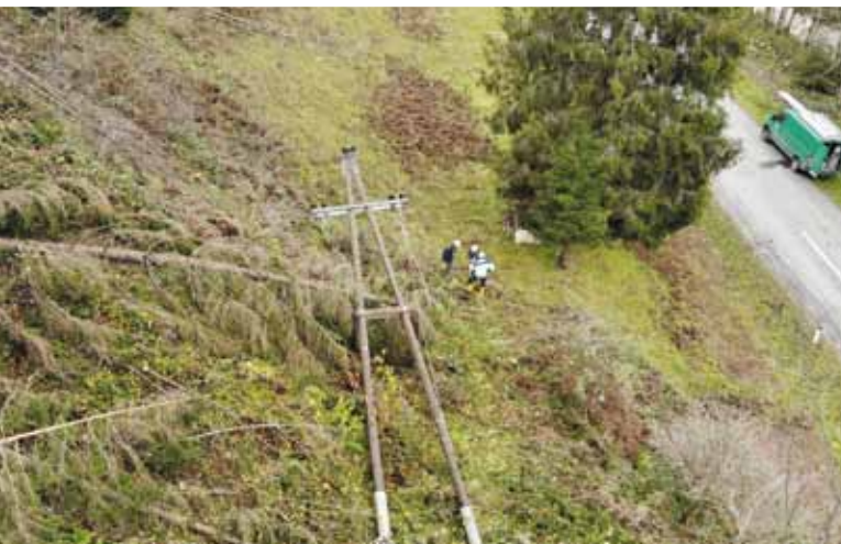
Die Monteure der KNG-Kärnten Netz GmbH und der Maschinenring beim Einsatz im steilen Gelände.
