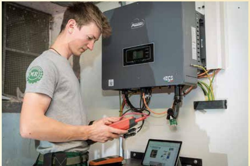
Maschinenring Photovoltaik-Prof Martin Rotschopf bei den Messungen für das Prüfprotokoll im Zuge der Erstinbetriebnahme.
