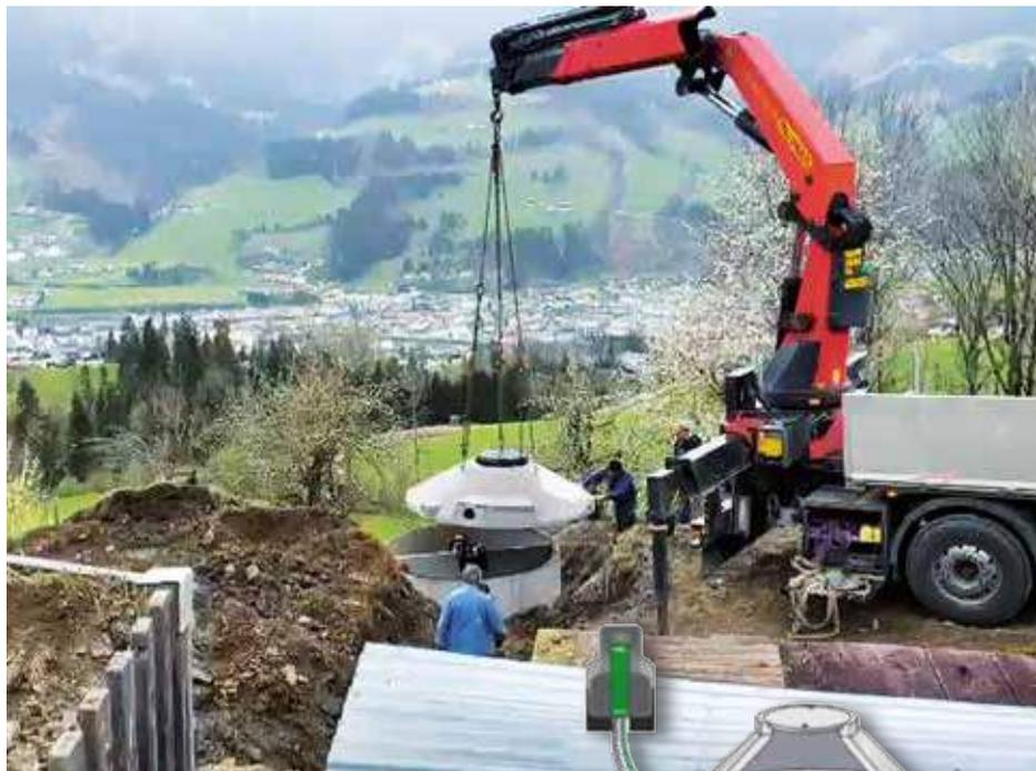
Einbau einer Kleinkläranlage auf einem alleinstehenden, nicht ans öffentliche Kanalnetz angeschlossenen Gehöft.
