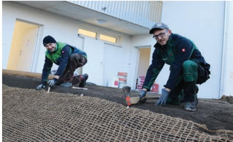
*Bild oben: Berni und Jürgen beim Verlegen von Böschungsnetzen.*
