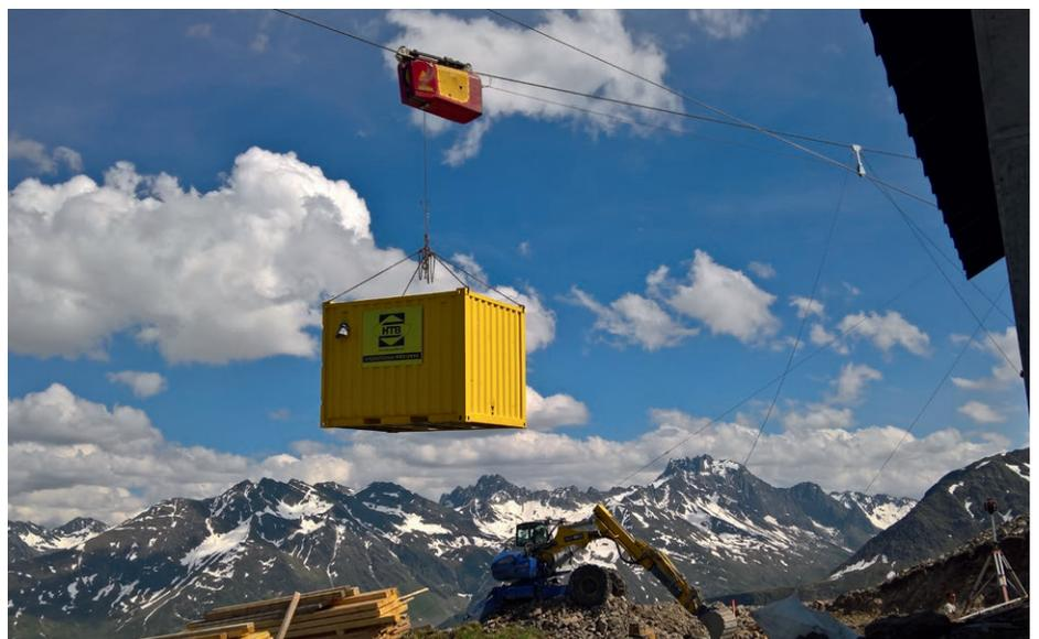
Arbeitsplatz mit Ausblick: Das Material für den Bau der neuen Bahn wird mithilfe der Seilbahn auf die Albona gezogen.
