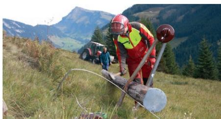
Die Masten werden von den Seilen und allen Metallteilen getrennt - damit alles separat entsorgt werden kann.
